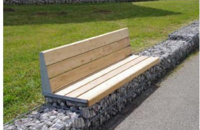
Principe du banc sur gabion
