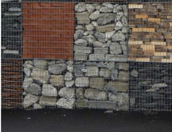
Principe des gabions rempli avec des « déchets »
